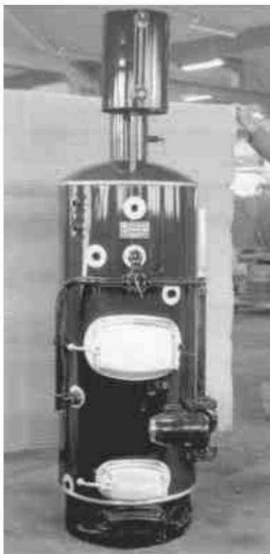
Tidig oljepanna från Gustavsbergs Fabriker i Reftele försedd med varmvattenberedare och ESBE-shunt.
